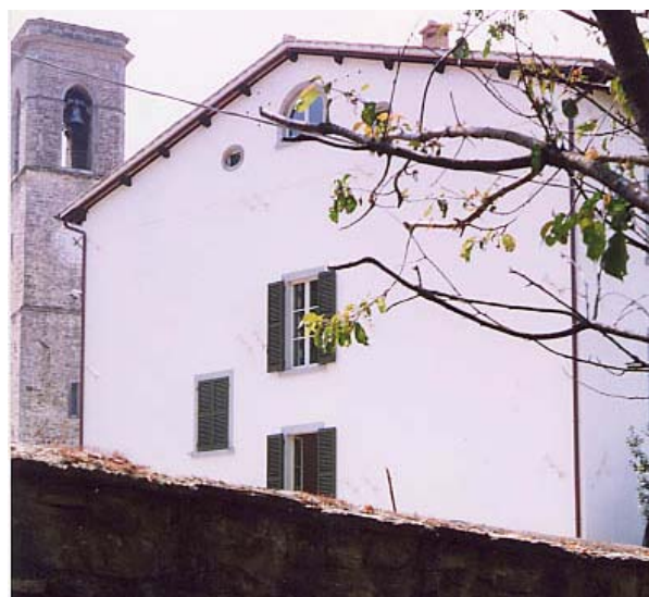
Lato verso via Lungo Savio.
