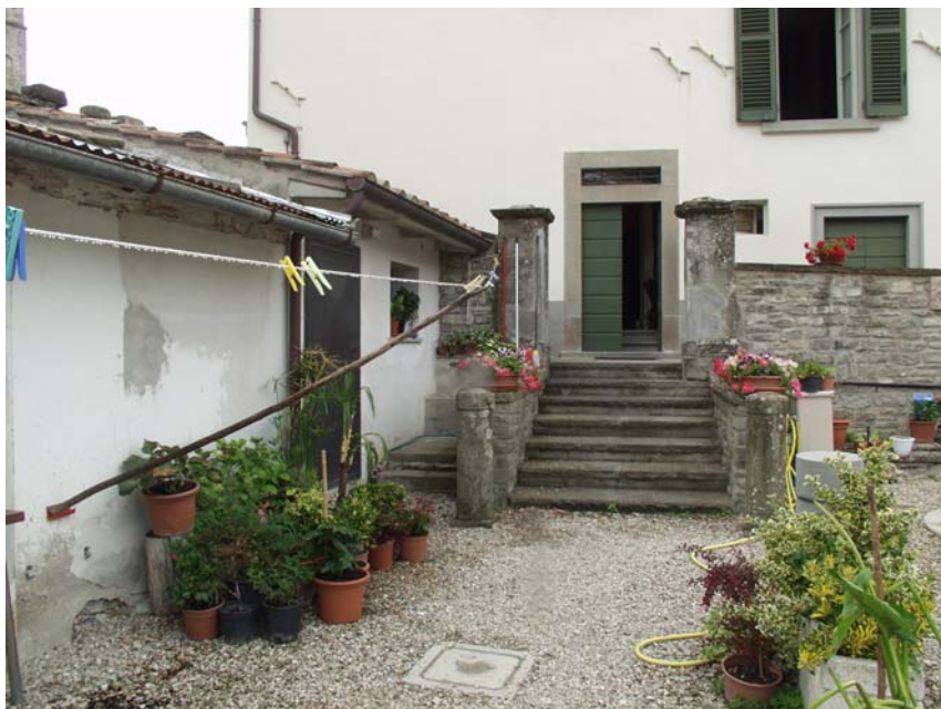
Interno del lotto: il raccordo con il fabbricato principale.
